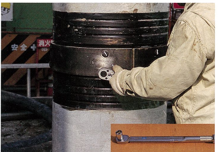
接続ボルトの締め付け
