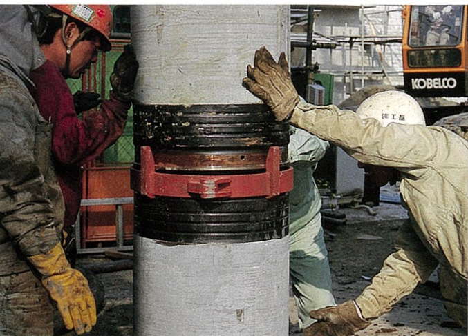
上杭の建込み
