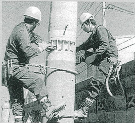
建込み継柱施工
